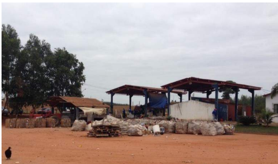
Figura 4-24 - Usina de Triagem e Compostagem.
